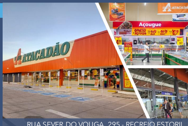
RUA SEVER DO VOUGA, 295 - RECREIO ESTORIL
