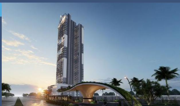
EDIFÍCIO RESIDENCIAL - CUIABÁ MT
