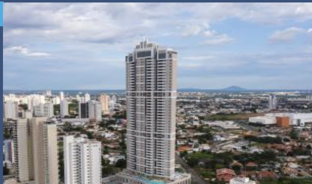
EDIFÍCIO RESIDENCIAL - CUIABÁ MT
