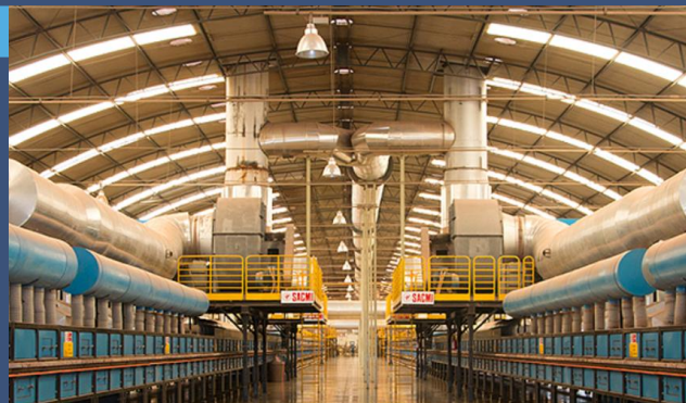
FÁBRICA E CENTRO DE DISTRIBUIÇÃO
