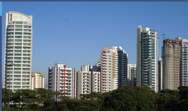
EDIFÍCIOS RESIDENCIAIS - SP
