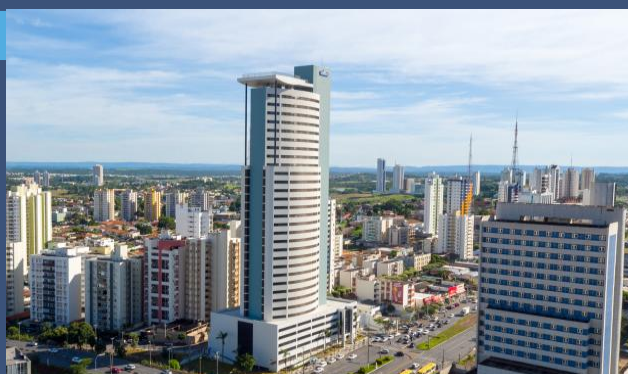
EDIFÍCIO COMERCIAL - CUIABÁ MT
