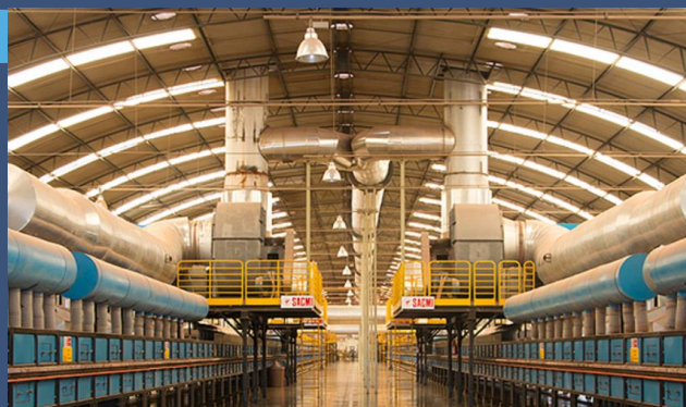
FÁBRICA E CENTRO DE DISTRIBUIÇÃO
