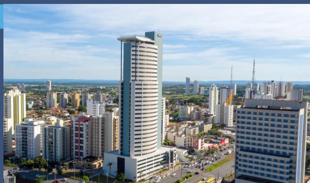
EDIFÍCIO COMERCIAL - CUIABÁ MT
