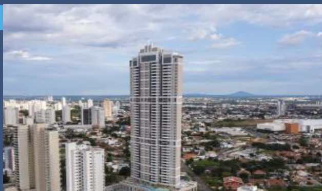
EDIFÍCIO RESIDENCIAL - CUIABÁ MT
