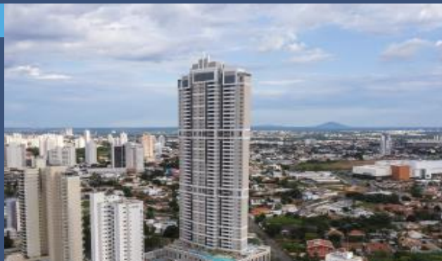
EDIFÍCIO RESIDENCIAL - CUIABÁ MT
