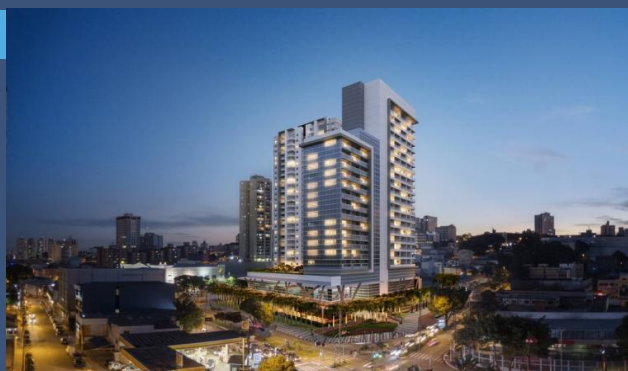
EDIFÍCIO RESIDENCIAL - SP
