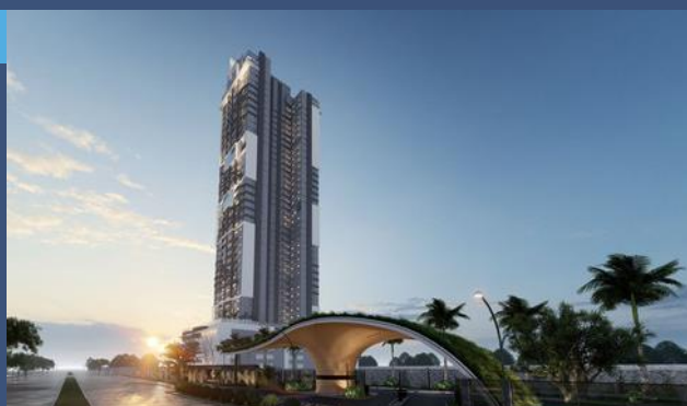
EDIFÍCIO RESIDENCIAL - CUIABÁ MT
